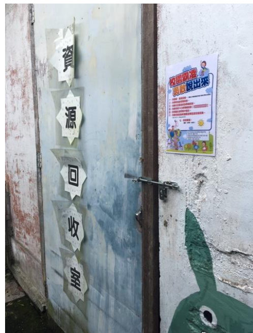
杜絕霸凌校園角落張貼警示標誌。
