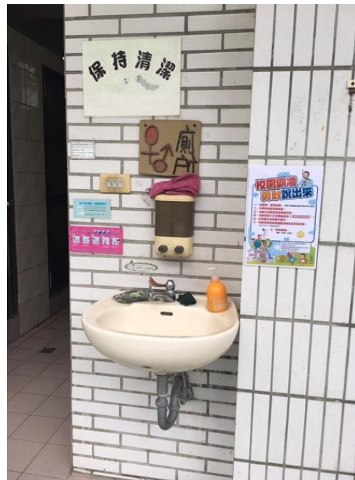
杜絕霸凌校園廁所張貼警示標誌。
