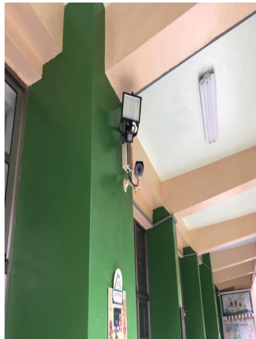
校園裝設攝影機及夜間照明設備。
