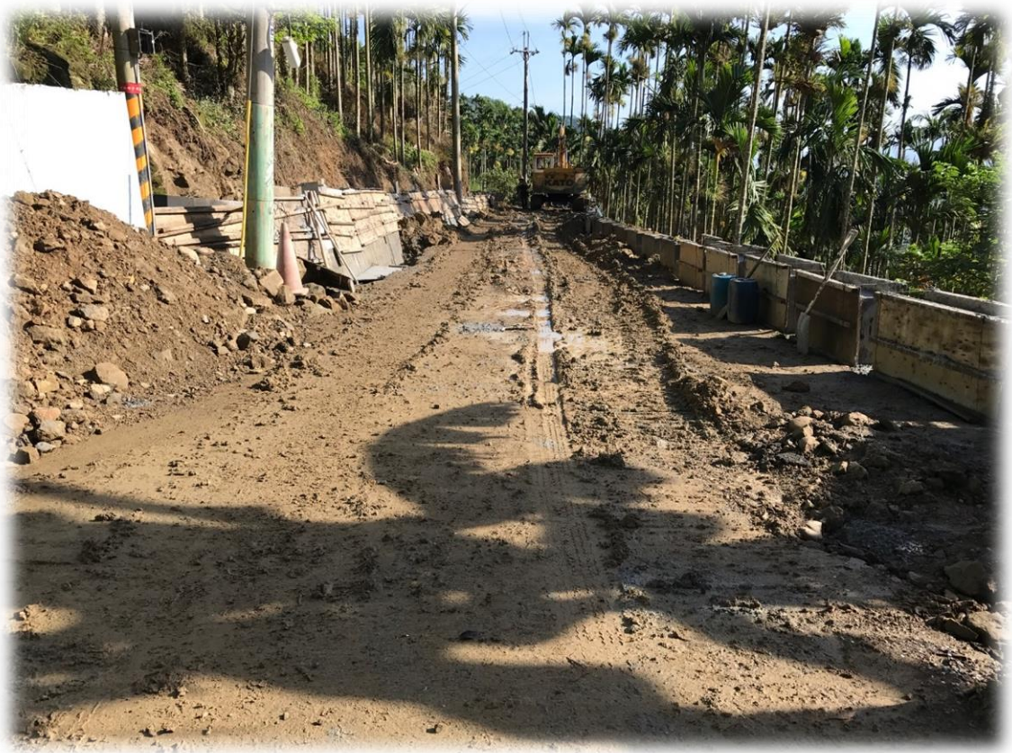
說明：校門口聯外道路施工照片
