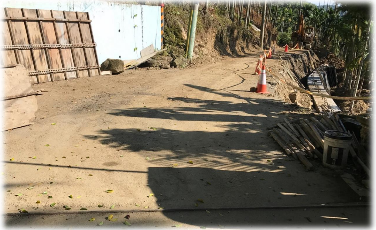
說明：校門口聯外道路施工照片
